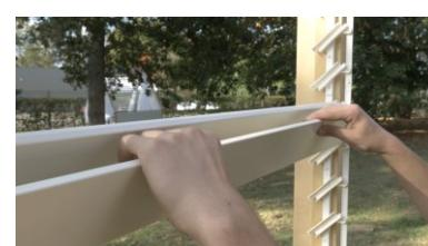
7. Schieben Sie die Lamellen in die Halterungen, indem Sie abwechselnd auf der Seite. Erst links, dann rechts.
