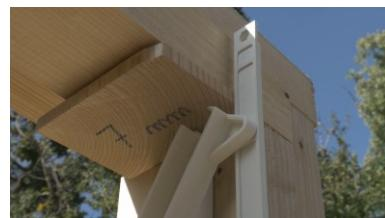
1. Oben am Panel den SAM-Bausatz mit einer 7mm-Keilplatte positionieren, die Stangen nach innen gerichtet. (\*siehe Fußnote).
