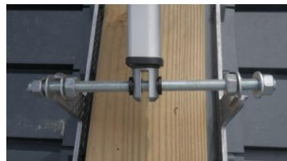
3. Schließen Sie die Lamellen manuell an der Pergola und setzen Sie die Gabelachse auf die beiden Metallstangen.
