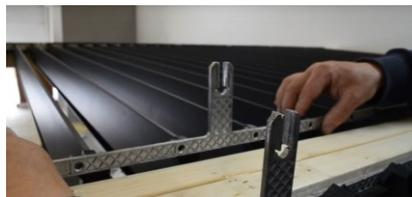
1. Ersetzen Sie die Stangen durch die Aluminiumgabeln, indem Sie sie in die Lamellenträgern einclipen. Positionieren Sie sie in der Mitte der Bausätze. Sichern Sie die Montage mit den Riegeln.
