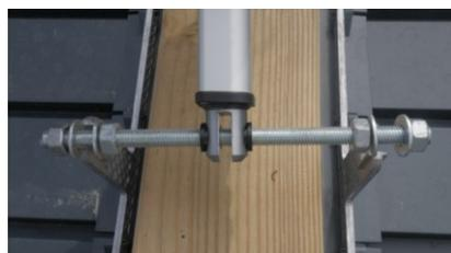
3. Fermer manuellement les lames de la pergola et insérer l'axe fourchette sur les deux tringles métalliques.
