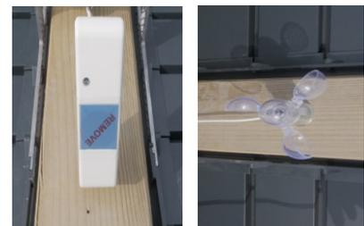
9. (option) Positionner les différents capteurs (pluie, température et vent) sur la structure de la pergola. S'assurer qu'ils seront suffisamment exposés pour détecter les variations climatiques recherchées. Se référer à la notice pour le raccordement des capteurs sur le boîtier.
