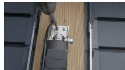
4. (Bis) Befestigen Sie die Zylinderhalterung an der Struktur, wobei darauf zu achten ist, dass die Lamellen der Pergola immer fest geschlossen sind..
