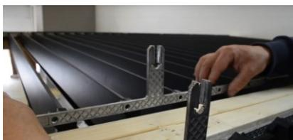
1. Remplacer les tringles par les fourchettes aluminium en les clipsant dans les supports de lame. Les positionner au milieu de l'ensemble des kits. Verrouiller le montage avec les loquets.
