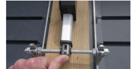
4. Drücken Sie leicht auf den Zylinder oder die Gabeln, um sicherzustellen, dass das Schließen vollständig ist, bevor Sie die Halterung befestigen.
