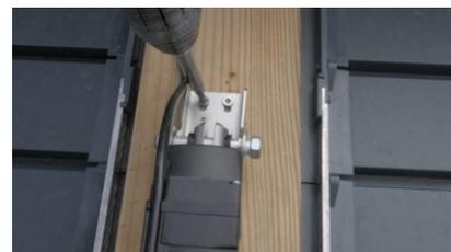
4. (Bis) Fixer le support du vérin sur la structure en s'assurant que les lames de la pergola soient toujours bien fermées.
