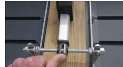
4. Appuyer légèrement sur le vérin ou sur les fourchettes pour que la fermeture soit totale avant de fixer le support.
