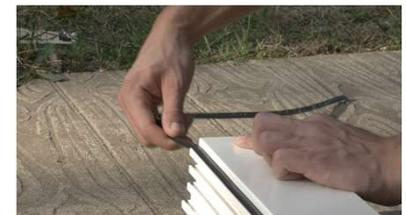
6. Insérer le joint pour les lames aluminium de 18mm. Soulever la languette du support pour insérer la lame.
