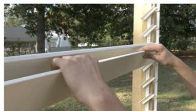
7. Pousser les lames dans les supports, en tapant alternativement du côté gauche puis droit.
