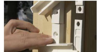
4. Clipser et visser les parclose des KITS à la suite. Laisser encore 7mm entre le dernier kit et la poutre (idem étape 1 et 2)
