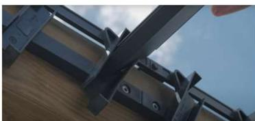
7. Insérer les lames dans les supports, en tapant alternativement du côté gauche puis droit.
