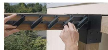
6. En bout de travée, placer le dernier kit avec la cale de 7mm. Scier le superflu de tringle (idem étape 1 et 2).
