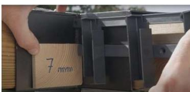
1. Positionner le KIT SAM au bout de la poutre avec une cale de 7mm. (**\*voir bas de page**)
