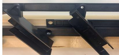
1. Le kit SAM doit être fixé à 15mm du bord du poteau (utiliser la tringle PVC comme gabarit).
