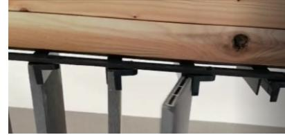
7. Schieben Sie die Lamellen in die Halterungen, indem Sie abwechselnd auf der Seite.
