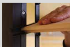
Pousser les lames dans leurs logements.
