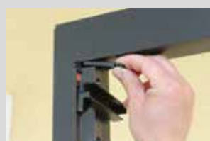
Positionnement du kit SAM avec cale de 7mm en partie haute du support.
